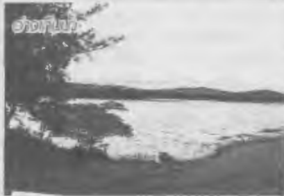
ปากทอระบายน้ำช่วงน้ำหลาก
