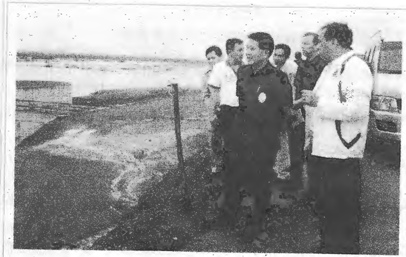
ติดตาม-นายเลศวิโรจน์ โกวัดนะ อธิบดีกรมชลประทาน และคณะ ลงพื้นที่ตรวจเยี่ยมโครงการก่อสร้างอ่างเก็บน้ำคลองหลวงรัชชโลทร อ.เกาะจันทร์ ที่เมื่อก่อสร้างแล้วเสร็จจะสามารถเก็บน้ำได้ 98 ล้านลบ.ม. ช่วยบรรเทาอุทกภัยให้ประชาชนในเขต อ.พานทอง อ.พนัสนิคม อ.เกาะจันทร์ และ อ.เมือง จ.ชลบุรี
