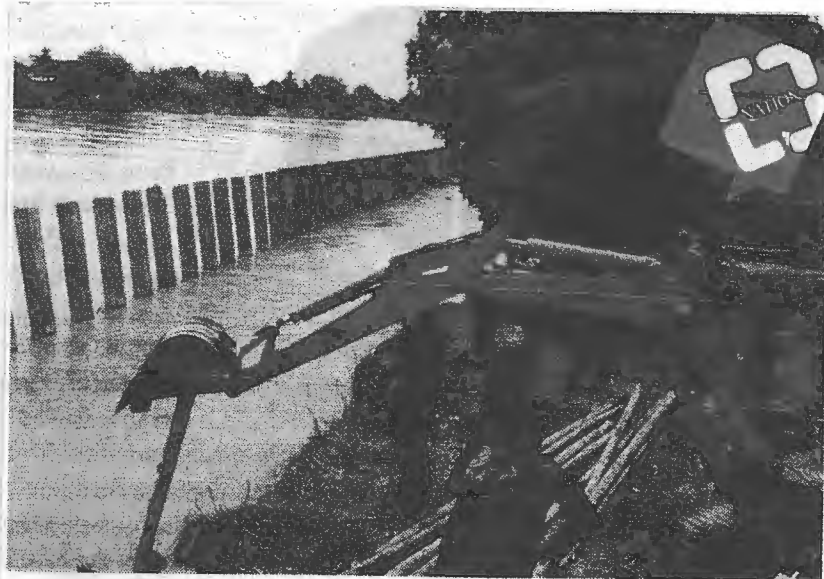
กันตลิ่งพัง : ทหารกองพันซ่อมบำรุง กรมสนับสนุน กองพลทหารม้าที่ 2 รักษาพระองค์ เร่งนำเครื่องจักรตอกเสาเข็มตลอดแนวตลิ่งริมแม่น้ำเจ้าพระยา ฝั่งทิศเหนือ ต.โทรน้อย อ.บางบาล จ.พระนครศรีอยุธยา เพื่อป้องกันตลิ่งพัง หลังเขื่อนเจ้าพระยาระบายน้ำเหนือเข้ามาในพื้นที่
