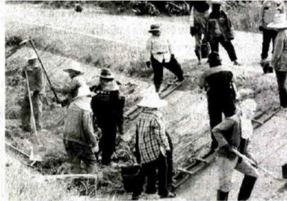
๑ ช่างชาวนา - ชาวนาในพื้นที่ จ.อุตรธานีรับจ้างจากโครงการชลประทานอุตรธานี ทำความสะอาด เก็บคันหญ้า ซ่อมแซมคลองส่งน้ำ โดยรับค่าแรงวันละ 300 บาทเป็นเวลา 5 เดือน เพื่อชดเชยการให้จดทำมาปริงเนื่องจากภัยแล้ง
