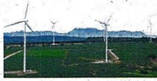
สปก.ส่อยกเลิกทุกสัญญา โรงไฟฟ้า'พลัฆานลม'
