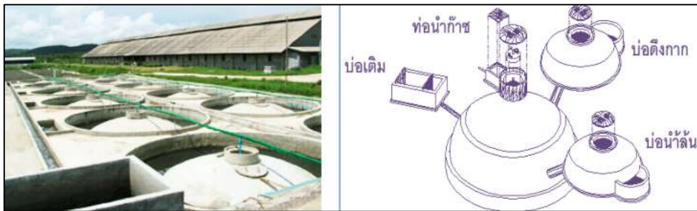
ภาพที่ 3.3 บ่อหมักแบบโดมคงที่ (Fixed dome digester)
