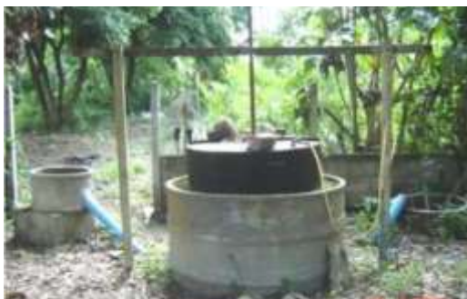
ภาพที่ 3.4 บ่อหมักแบบฝากรอบลอย (Floating drum digester)
