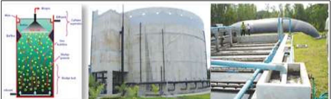
ภาพที่ 3.7 บ่อหมักแบบ UASB และ H-UASB
