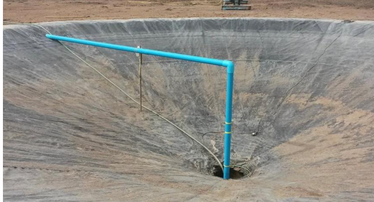
ภาพที่ 4.9 หลุมกลางบ่อ ที่ใช้รองรับตะกอนเลน เศษซีเมนต์ และแพลงตอน
